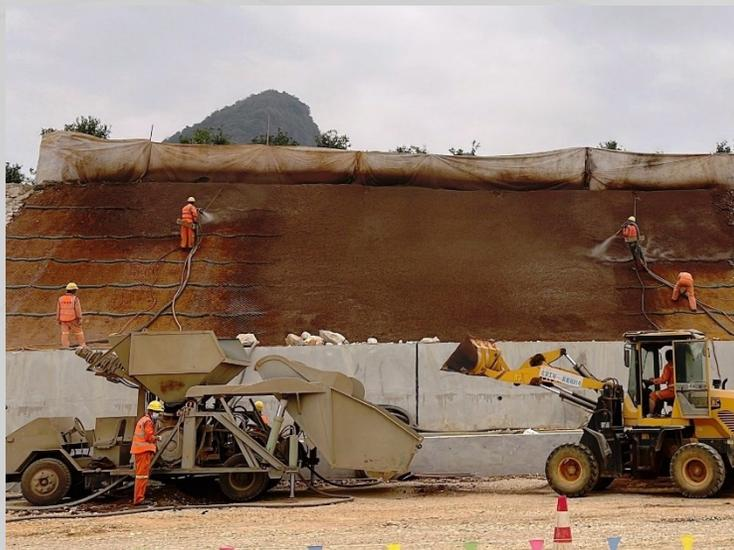
可拌合生产SSP系列稳定土植生护坡基材，和喷混植生、改良客土等边坡绿化用混合物料。
